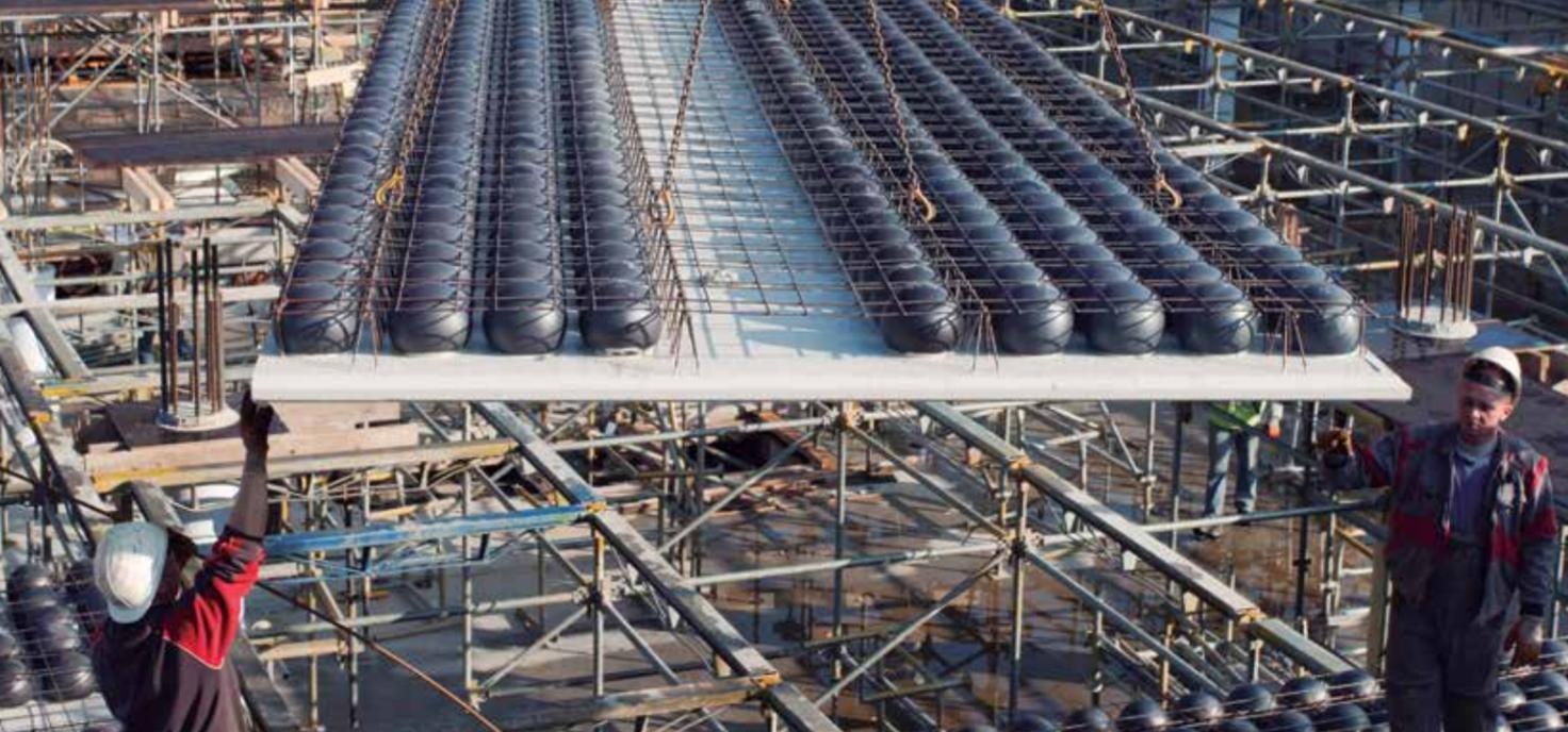
El sistema BubbleDeck está basado en la tecnología patentada de unir aire y acero para alivianar la losa y obtener una estructura funcional con ausencia total de vigas.
